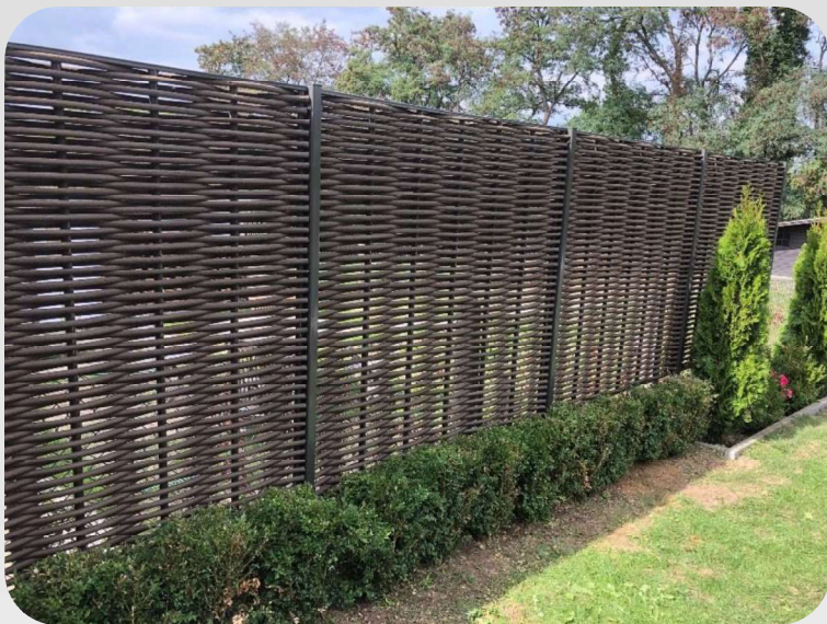
Panneaux profil T avec poteaux métalliques
