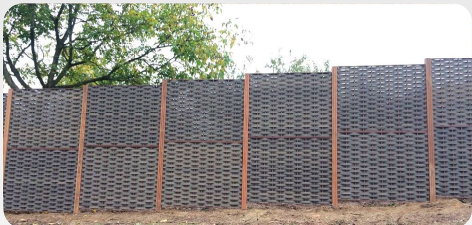
Panneaux standard empilés pour créer une hauteur supérieure
