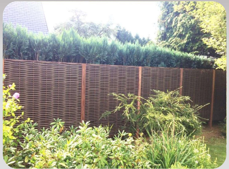
Tressage simple avec des poteaux en bois tropical
