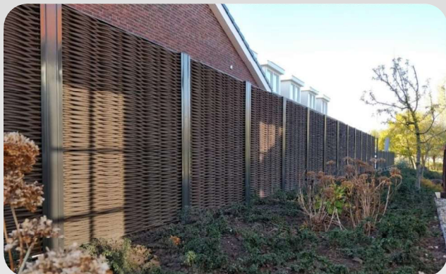
Tressage double avec poteaux 80x80 mm
